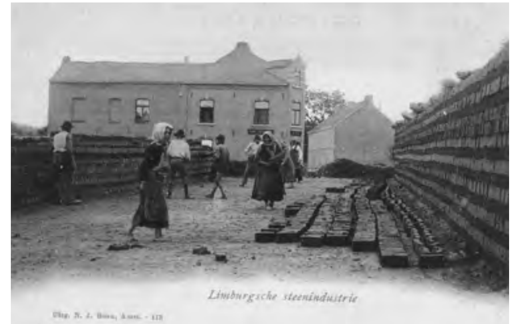
Deze foto geeft een beeld van hoe het er rond 1900 in de steenindustrie in Limburg aan toe ging: vrouwen en meisjes hielpen mee bij het stapelen en uitleggen van stenen. De foto is vermoedelijk genomen te Meerssen. (coll. G.A.V.)
