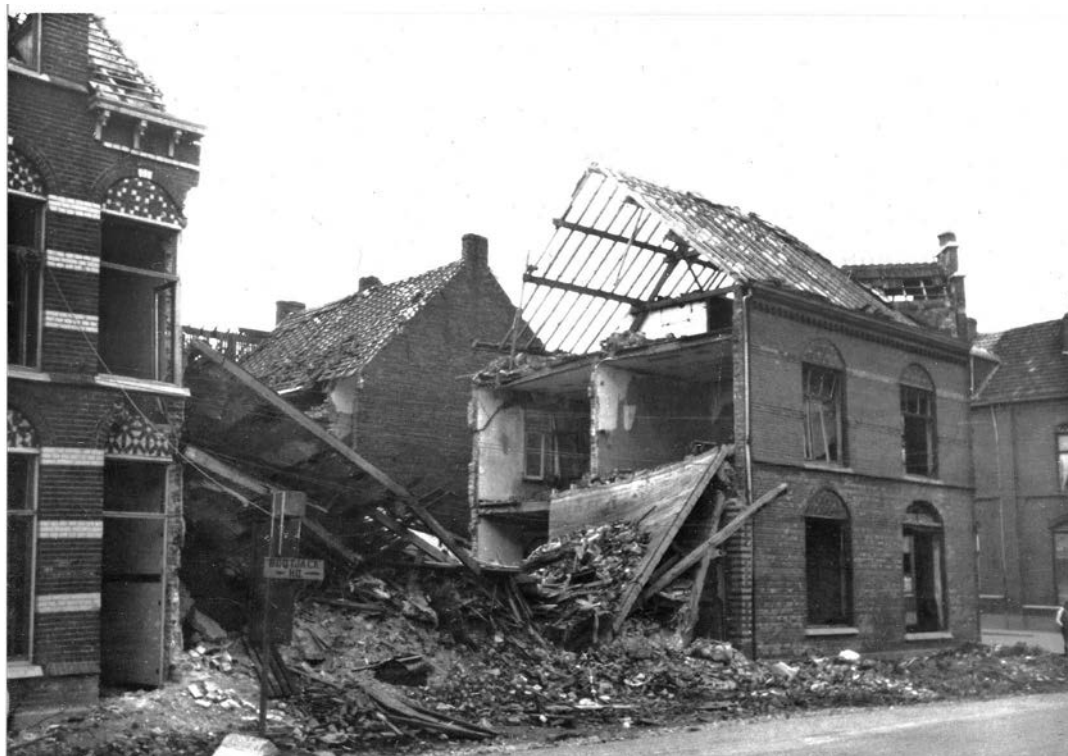
Enkele getroffen panden in de Ginkelstraat
